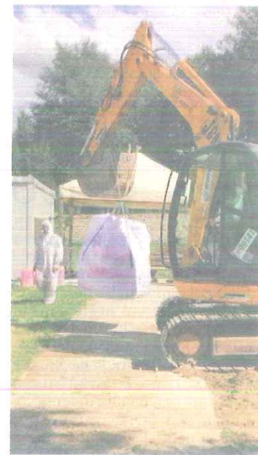
I lavori nella scuola
