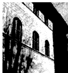
Palazzina Coppi In via Buonarroti, accanto al mercatino di piazza dei Ciompi, è un edificio di pregio su più piani
