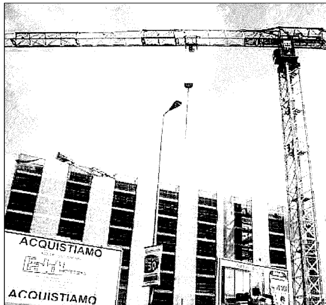
Il cantiere a Novoli
