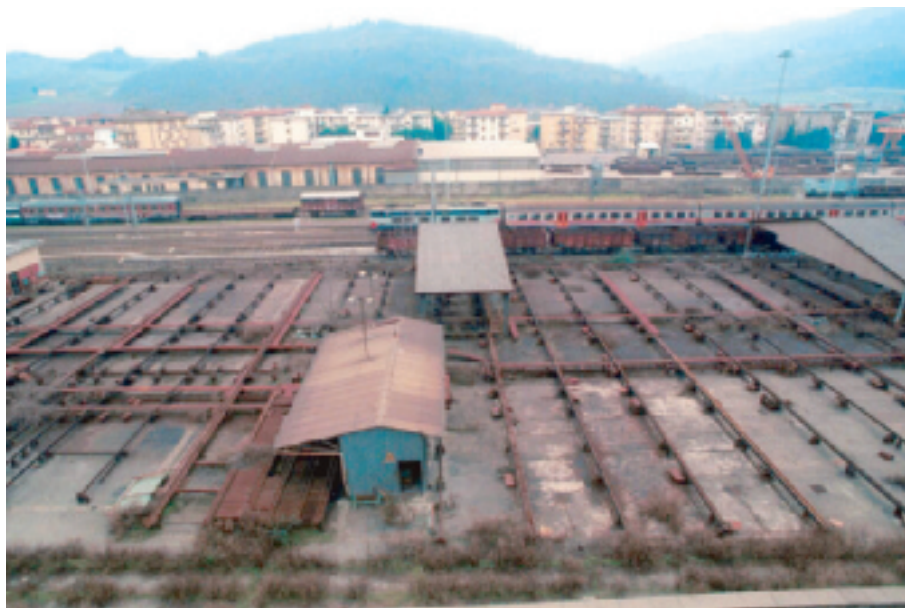
ABBANDONO L'ex area ferroviaria in attesa di riqualificazione da dieci anni
